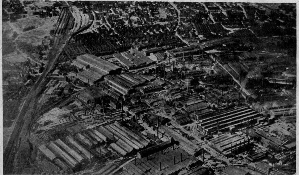
Fabrizianlagen der Krupp'schen Eisenwerke, eines der grössten in der Welt.
