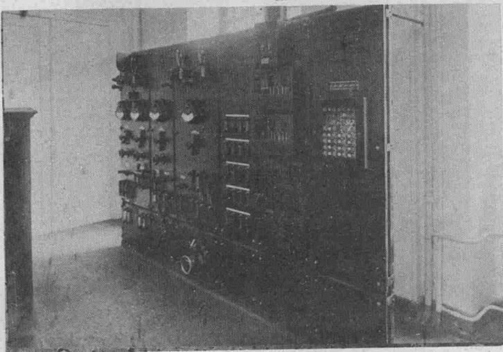
Tableau de charge avec les organes de contrôle et les machines d'appel.
