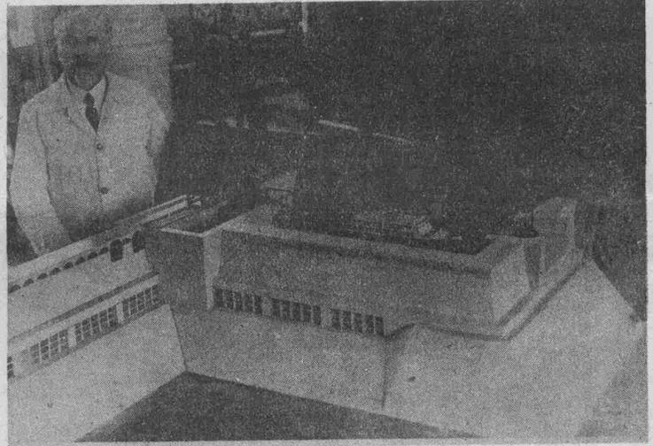
Die Schiffbarmachung des unteren Kongolaufes. Der belgische Genieoberst Van Deuren hat einen eigenartigen Plan zur Schiffbarmachung des Kongoflusses entworfen. — Modell einer Schleuse.
