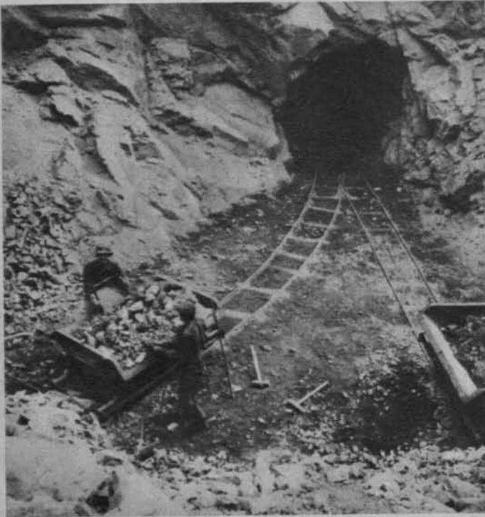
Eingang zu einer Grube. Auf den kleinen Wagen wird das Erz angefahren.
