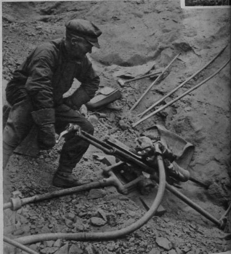
Bohrvorrichtung für die Schiesslöcher.
