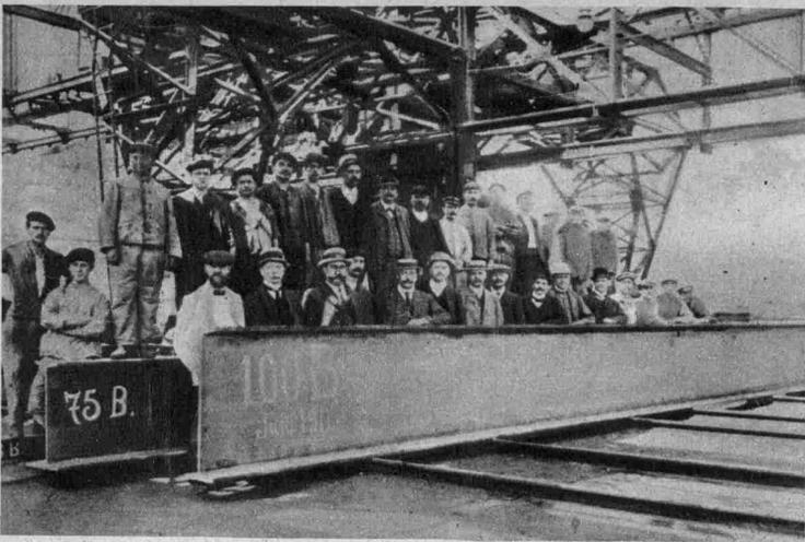
Bild 233. - Der erste Greyträger von 1 m Höhe wurde in Differdingen im Juni 1911 gewalzt.
