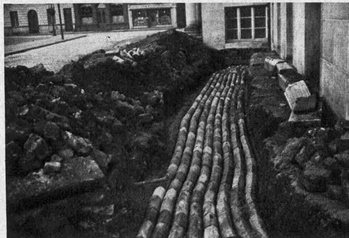
Kabellegung für die neue Hochspannungstation im neuen Stadthaus von Esch.
