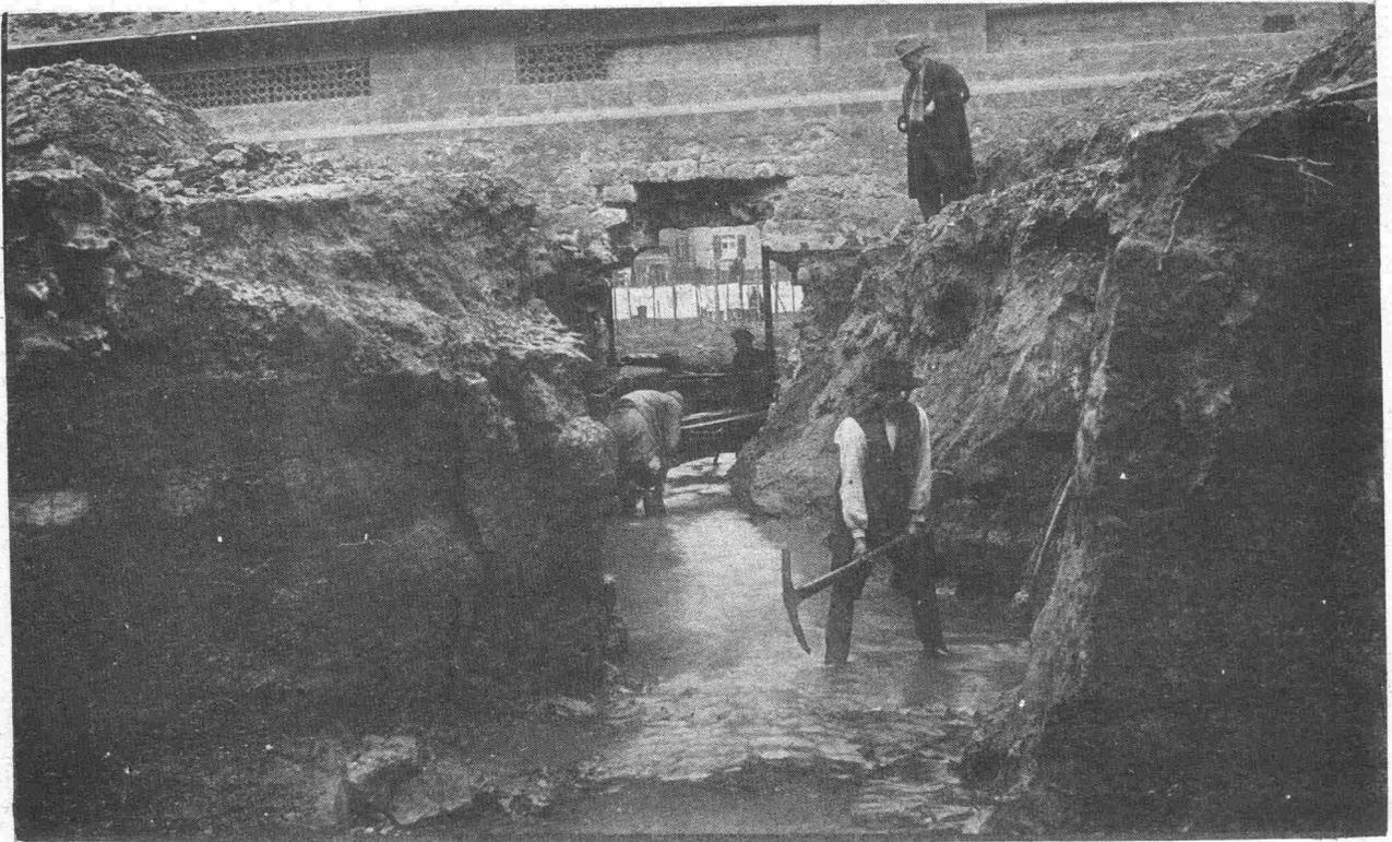
Hinterseite der 7 Brunnen. Zur Freilegung des Wasserlaufes musste die Strasse Luxemburg-Kopstal bis zu einer Tiefe von etwa 3 Metern durchstochen werden.
