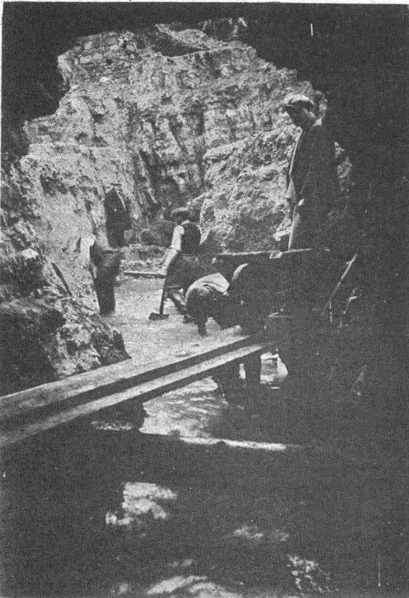
Die Arbeiten zur Säuberung des Bettes, zwecks späterer Einlegung der Röhren. In Halshöhe des rechts stehenden Arbeiters die Strasse Luxemburg-Kopstal.
