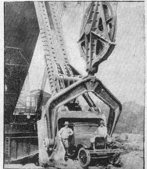
Diese Riesenschaufel ist in einem Kohlenbergwerk in Illinois in Betrieb. Sie kann das Material, Kohlen oder Sand, 26 Meter hoch, also bis zur Höhe eines 7stöckigen Hauses heben. Das Auto, das sich in der Schaufel befindet, illustriert das gewaltige Fassungsvermögen der Schaufel.
