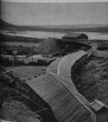
In einer Grube.
