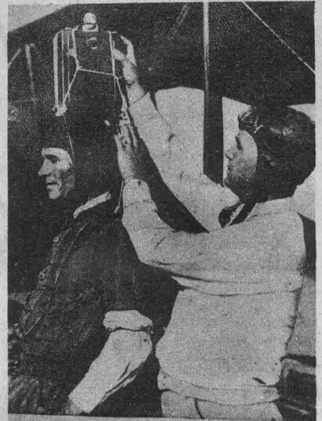
**Automatischer Filmapparat, der auf dem Kopf eines Fallschirmkünstlers befestigt wird und alle Phasen des Absturzes registriert.**
